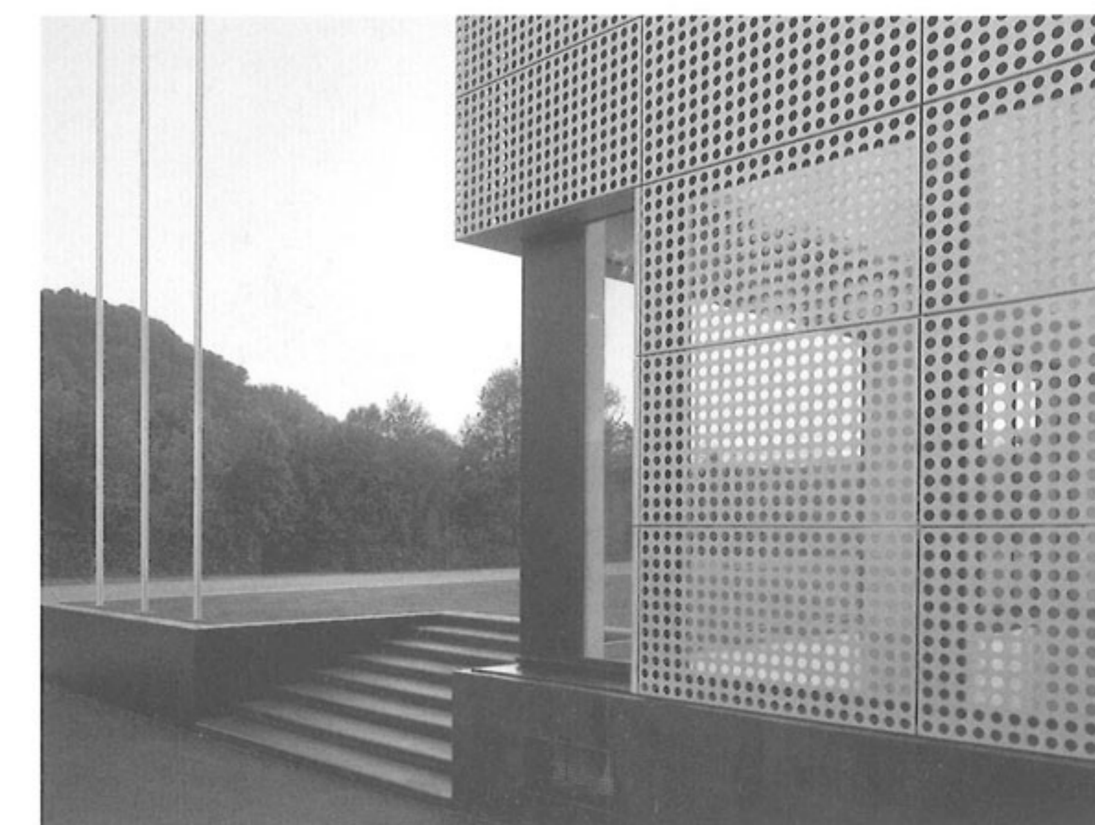
Eloxierte Lochbleche bilden die dünne Fassadenhaut.
