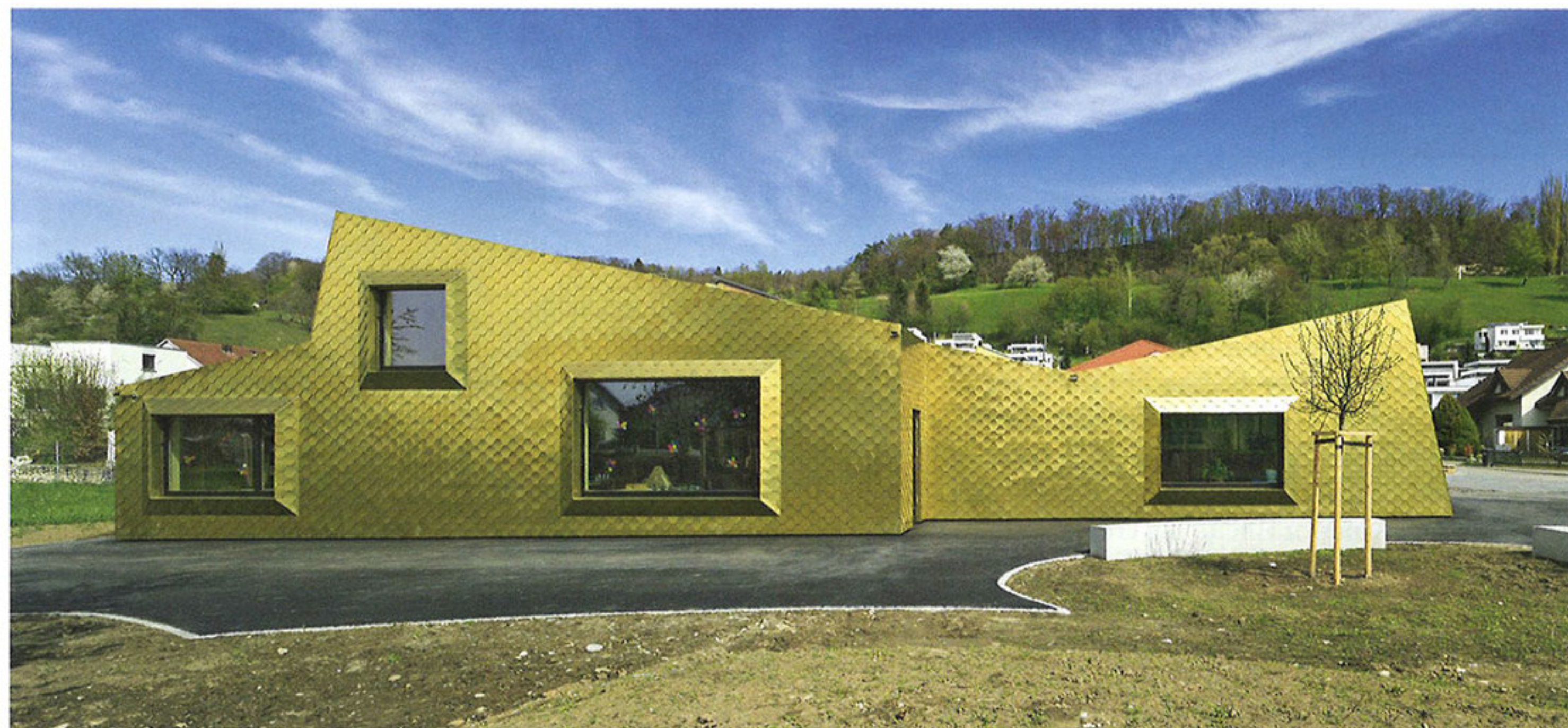
Bild 1. Kindergarten Zelgli West, Untersiggenthal: Südansicht
