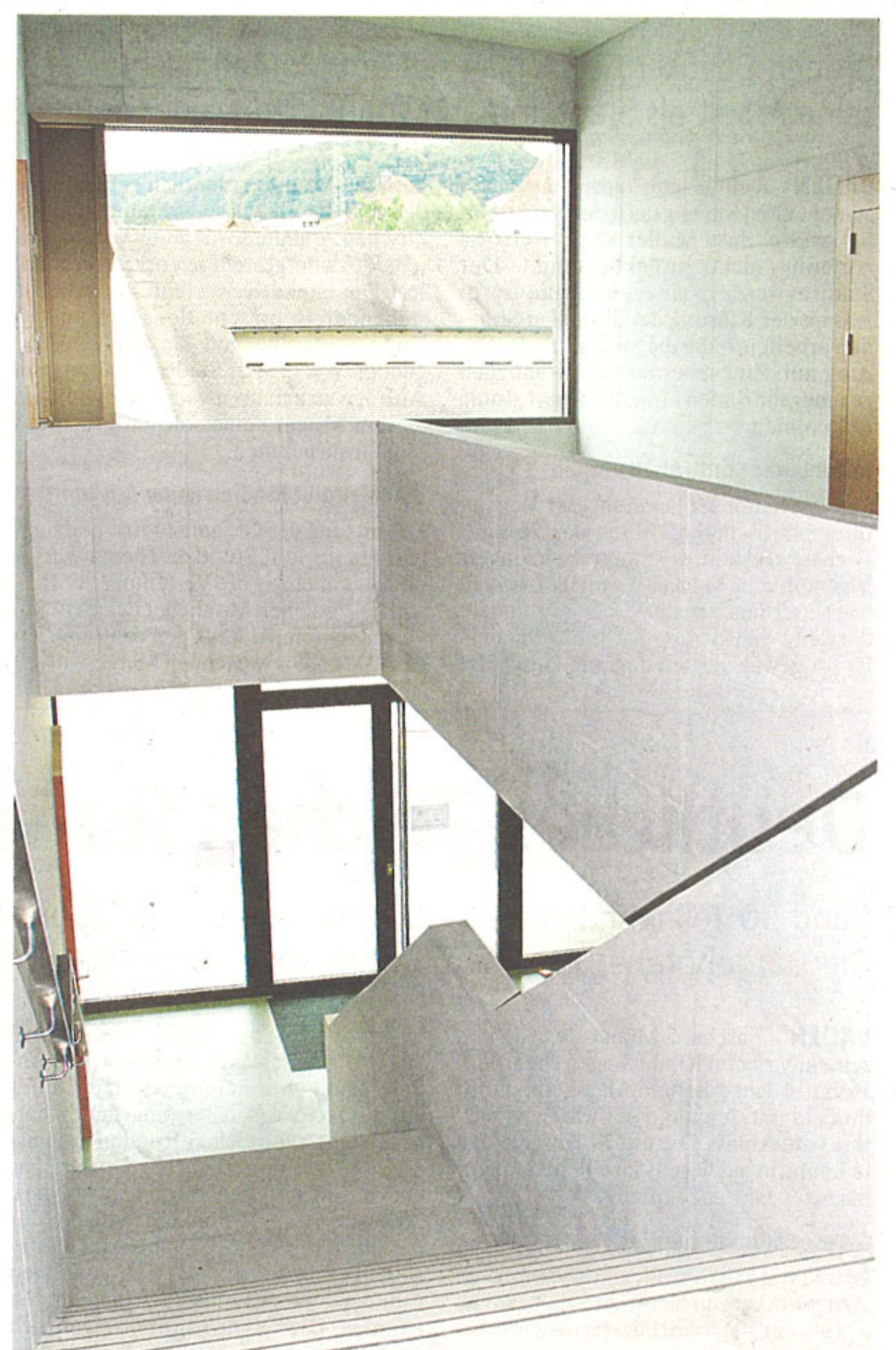
Die lichtdurchflutete Treppe verbindet das Erdgeschoss mit dem Obergeschoss.
