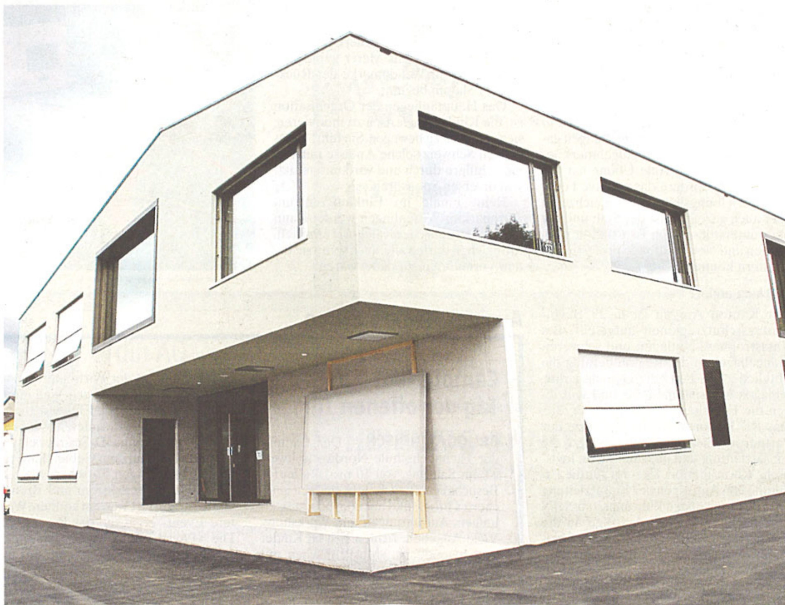
Das neue Schulhaus ist im Minergiestandard mit Komfortheizung gebaut worden.
