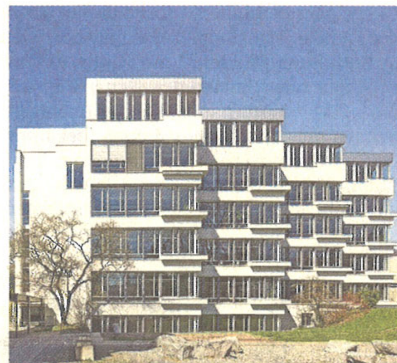
Die Aufstockung der drei Schulhäuser im Margeläcker in Wettingen führt die vorhandenen Qualitäten weiter. Eglin Schweizer Architekten AG, Baden / offen: So. 29. 5. 15–17 Uhr.
